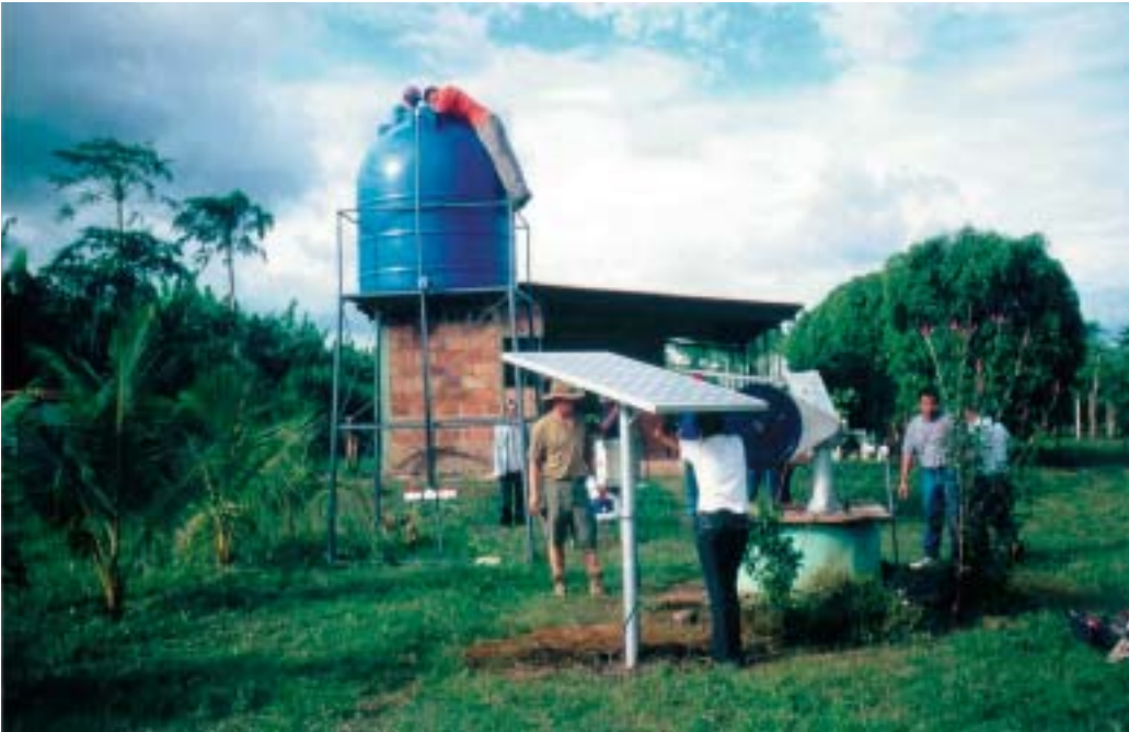
Photovoltaik zur Feldbewässerung in Nicaragua
