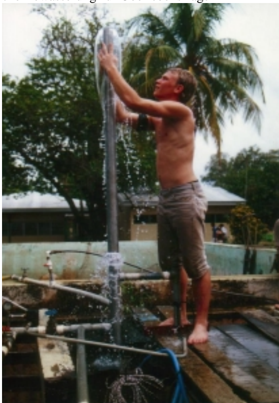
Erster Testlauf der solargetriebenen Pumpe
