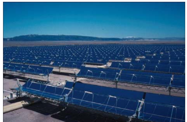
Parabolrinnenkollektorfeld für Solarthermische Kraftwerke in Kramer Junction, Kalifornien
